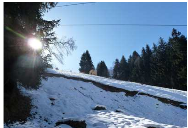
Rutschungsgebiet und bereits errichtete Hütte mit Messgerät
