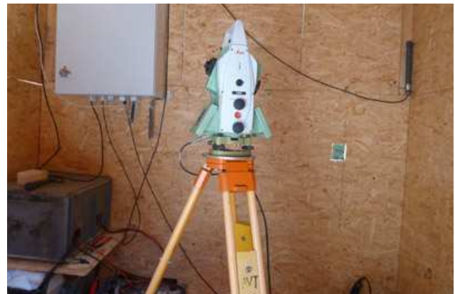
Blick in die Messhütte mit Tachymeter, Stromversorgung, Datenmanagement und Sendeeinheit
