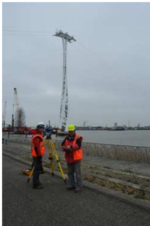
Das Vermessungsteam an der Themse in London - im Hintergrund die 90 m hohe Liftstütze der neuen Seilbahn
